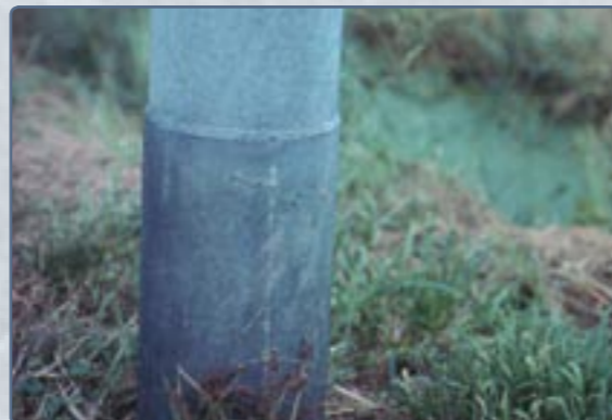
Opgewerkte lasnaad na het verzinken
